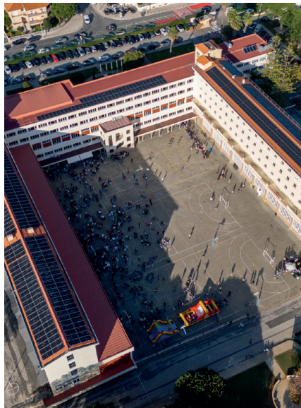
Planta fotovoltaica para Autoconsumo Colectivo en un colegio, Greenvolt.
